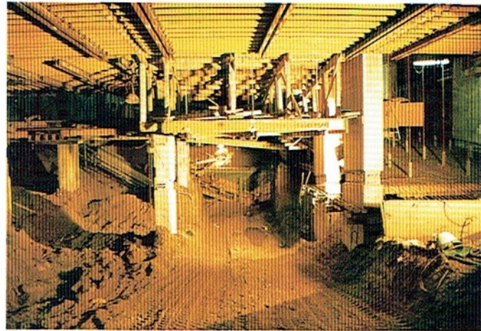
Bild 9: Förderbandaufgabe im Bereich der Split-Level-Rampen
