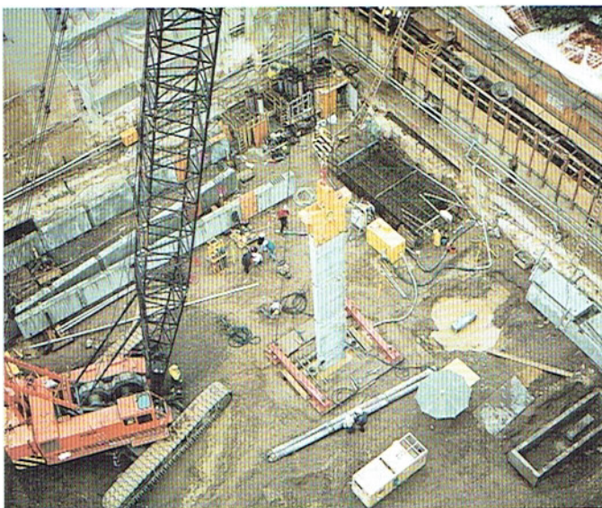
Bild 6: Ablassen einer Primärstütze mit angehängtem Bewehrungskorb
