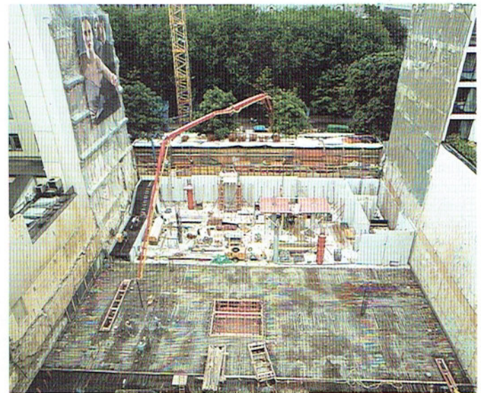
Bild 7: Betonieren eines Deckelabschnitts
